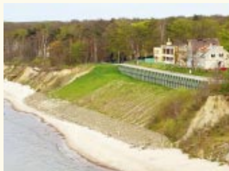
Piotr Domaradzki Obras de protección en Rewal, Polonia. El principal problema de erosión reside en la mala gestión del agua subterránea que favorece un aumento visible de la erosión en los alrededores.
